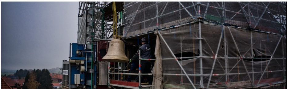
Glockentausch in windiger Höhe im Zuge der Sanierungsmaßnahmen.
